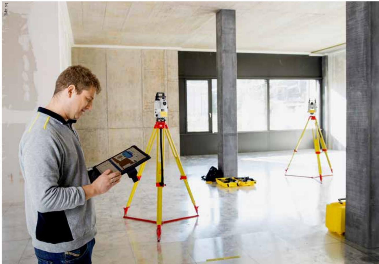
Die Totalstationen dienten beim Bau des Innovationsparks Zentralschweiz quasi als hochpräzise Baulaser: Sie übertrugen die Daten aus dem BIM-Modell auf die Wand.
